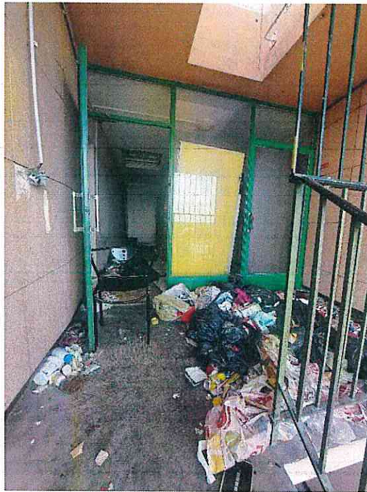
Figure 24: Entrée d'un étage du bâtiment 1.
