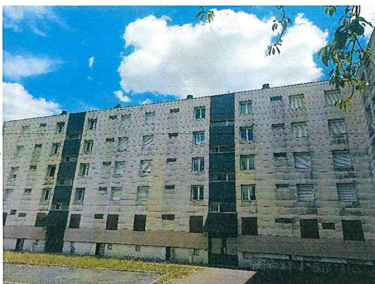
Figure 27: Façade du bâtiment 4
