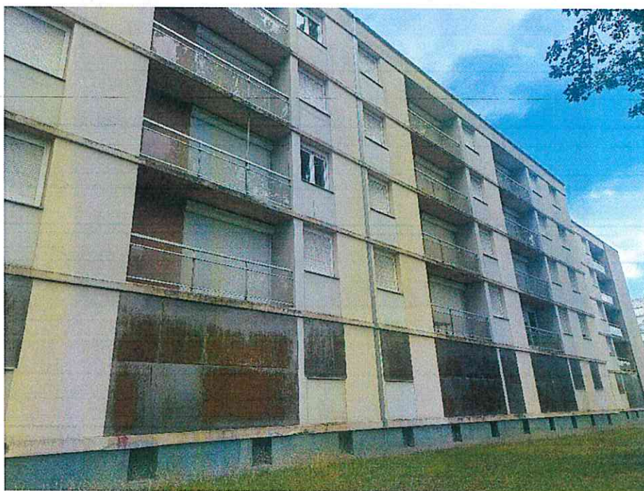
Figure 26: Façade Sud du bâtiment 3
