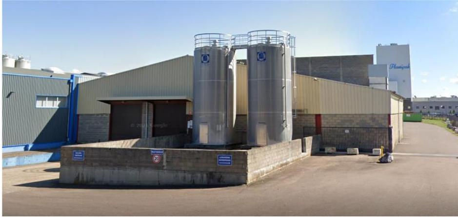
Figure 6 : Silos 7 & 8 présents sur la face Ouest du bâtiment – Ajout de deux silos à venir
