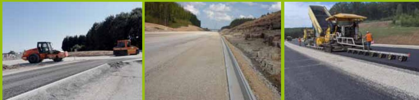
La structure du corps de chaussée a nécessité plus de 60 000 tonnes de matériaux mis en place en trois couches de nature différentes (matériaux traités au liant hydraulique et béton bitumineux) pour permettre à la route d'avoir une durabilité et un confort d'utilisation optimal.
