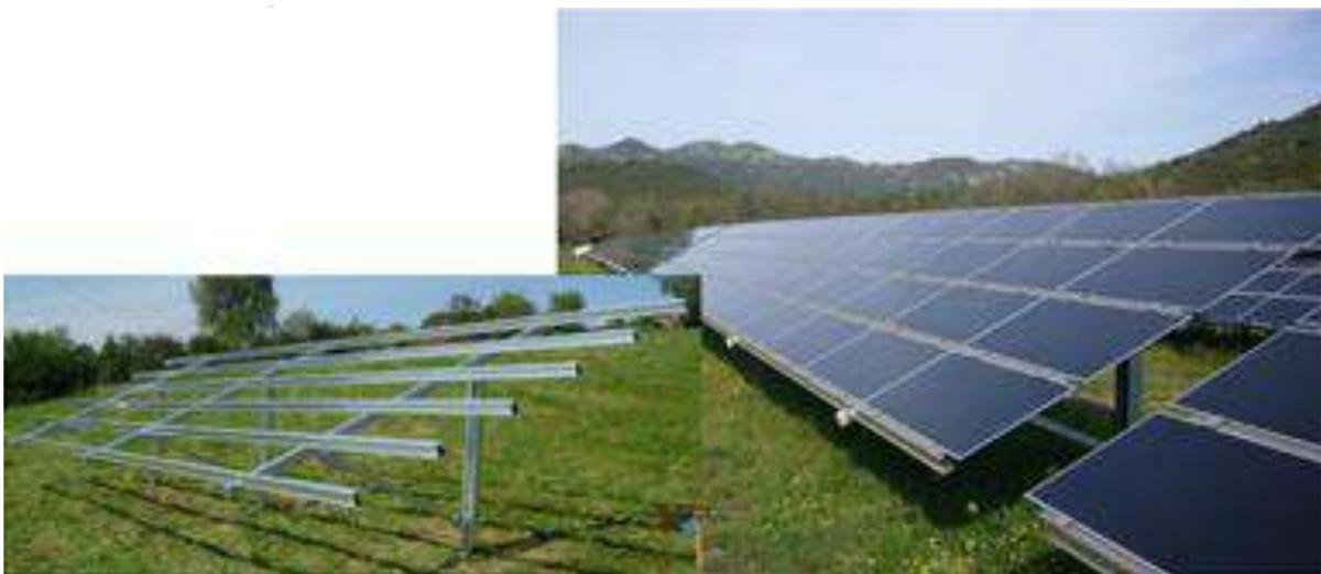
Figure 58 : Pose des tables photovoltaïques
