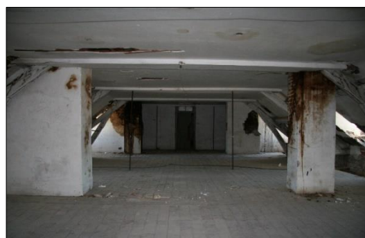
Etat de l'aile nord des combles
