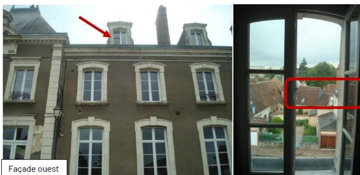
Figure 5 : Adaptation d'une des nouvelles fenêtres pour maintenir un accès aux combles pour les Chiroptères
