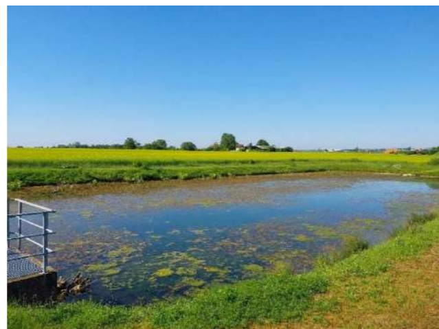
Bassin de rétention
