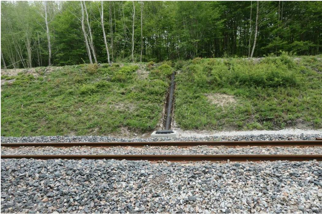
Figure 2 descente d'eau en béton sur talus qui évacue les eaux d'un fossé
