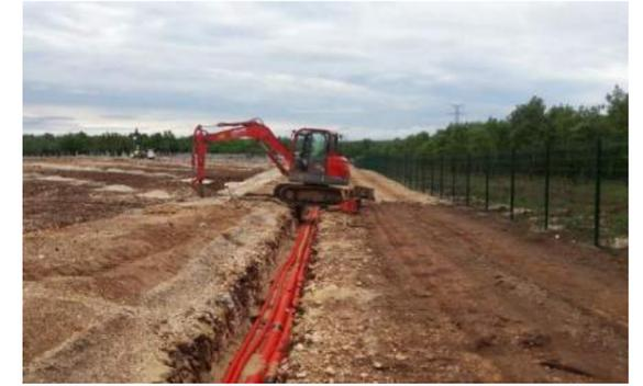
Ces travaux ne s'appliqueront pas au croisement de la ligne HTA Enedis enterré. Les câbles reliant les tables de modules aux locaux techniques devront cheminer à plus d'1m de la ligne et permettre l'accès d'Enedis à la ligne en cas de besoin.
