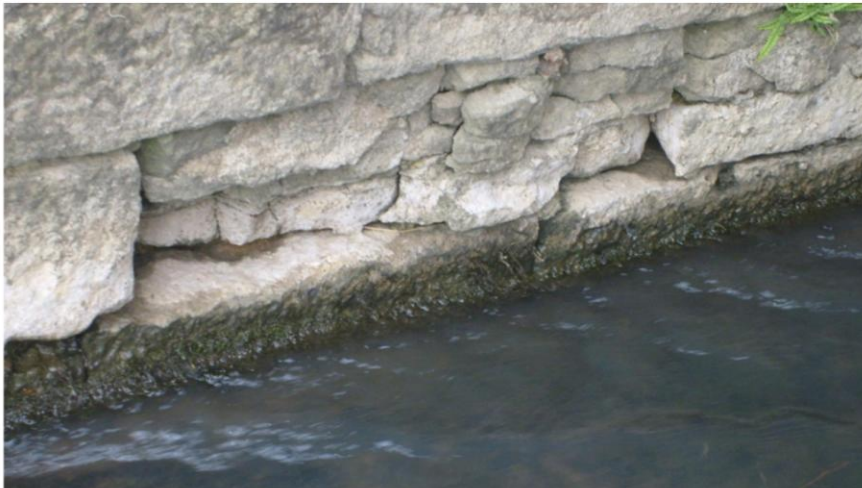
Partie basse d'une pile
