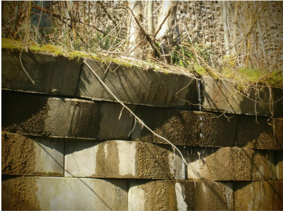
Drainage à l'arrière du mur de soutènement
