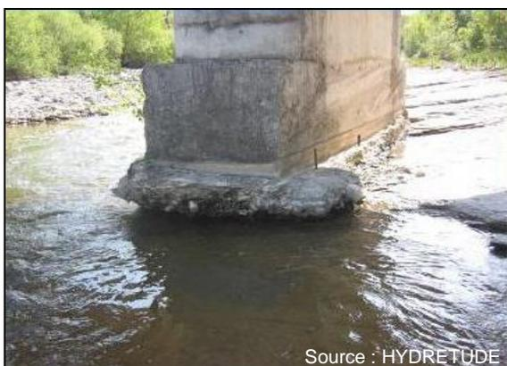
Photo 2 : L'Ouvèze à Rompon (Ardèche) : pont déchaussé par blocage du transport sédimentaire.
