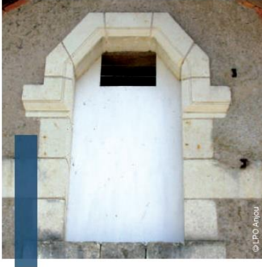
Exemple de la création d'une ouverture en haut d'une porte comblée (LPO Anjou)
