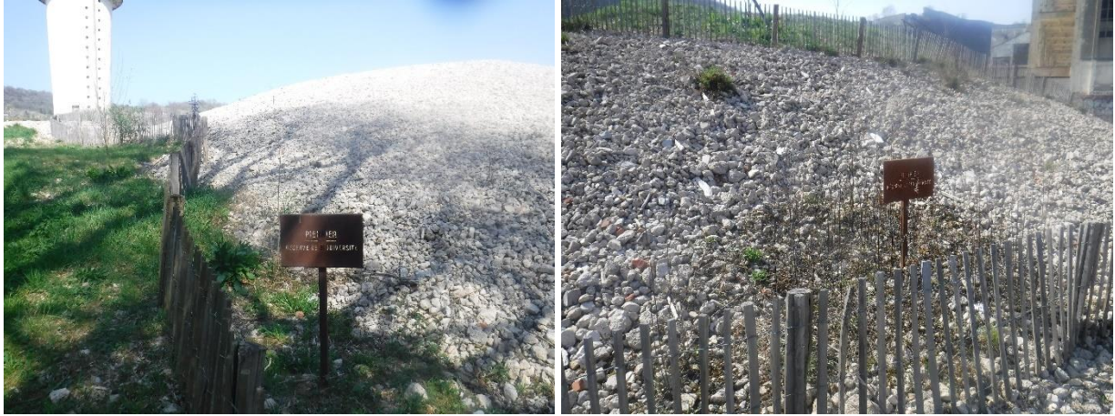
Photographies des deux pierriers
