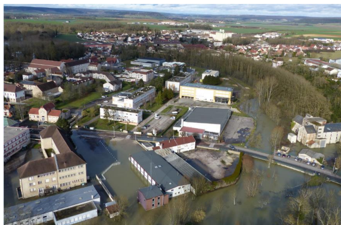
Inondation de Châtillon-sur-Seine au droit du moulin – janvier 2018
