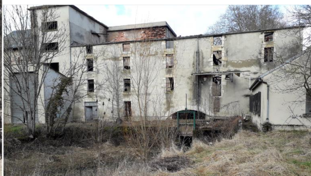
Moulin Lemoine avant sa démolition
