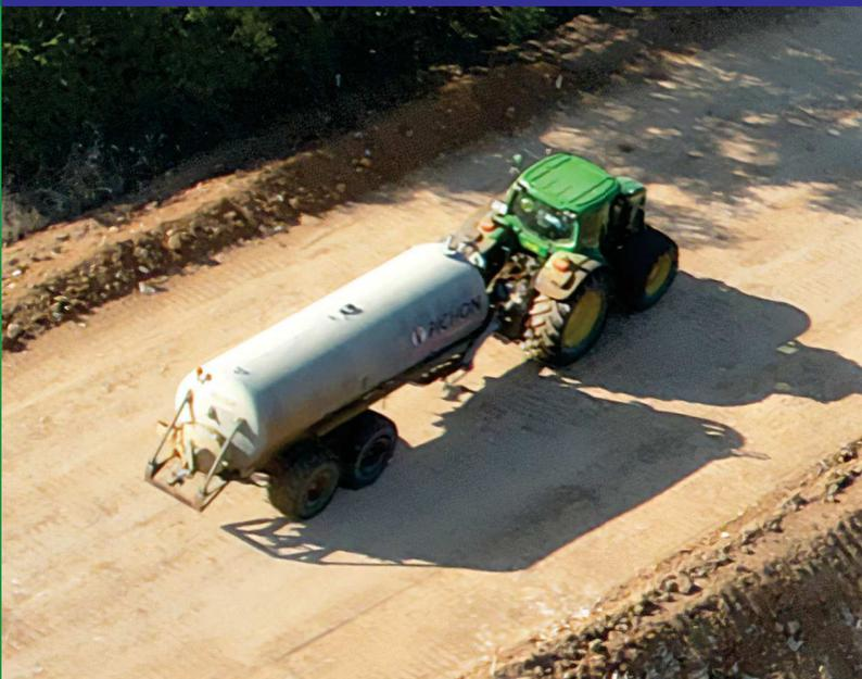
Le chantier, proche de nombreux riverains et de l'actuelle RN57, fait l'objet d'une procédure d'arrosage des pistes de circulation des engins permettant de limiter l'envol des poussières.
