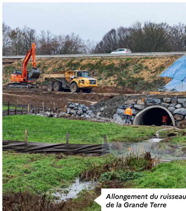
Prolongement d'un ouvrage hydraulique
