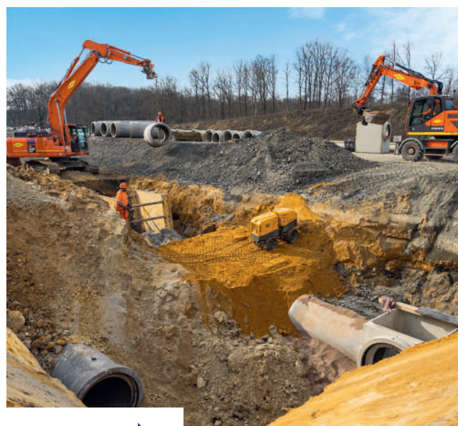
Le chantier va s'organiser jusqu'en juillet 2024 sur une période de 24 mois.
