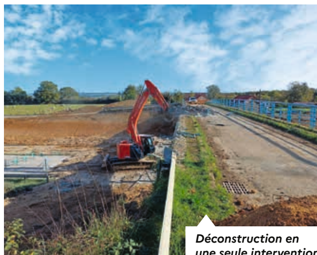
Un pont trop étroit démoli
