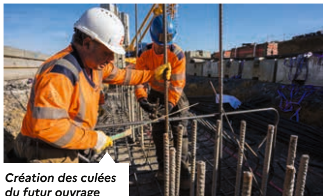
Déconstruction en une seule intervention
