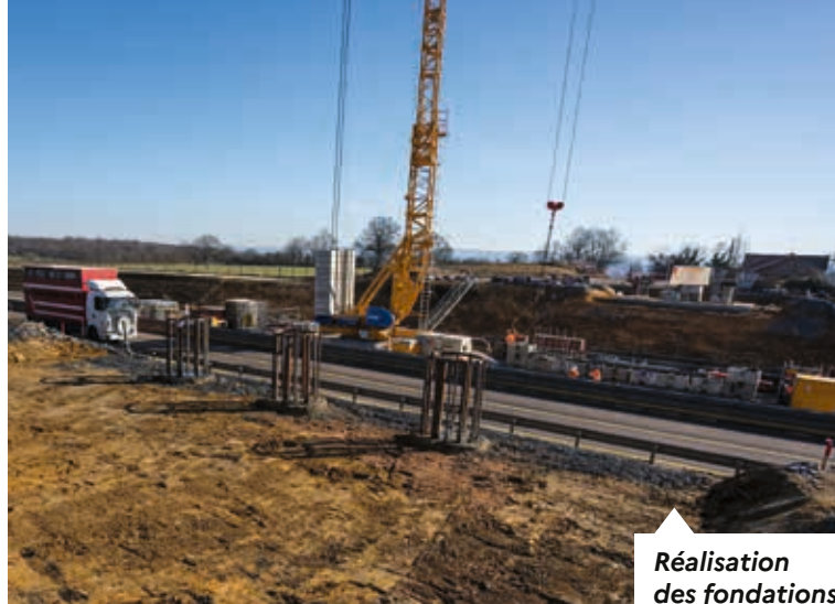
Forage des pieux de fondations des futures culées
