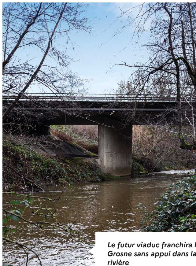
Vue sur la Grosne et sa végétation de berge (ripisylve)
