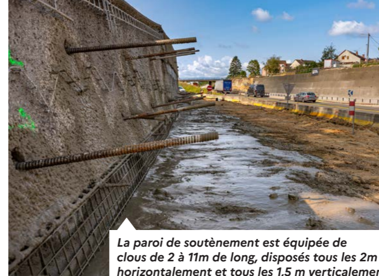
La construction se fait du haut vers le bas, par phases successives
