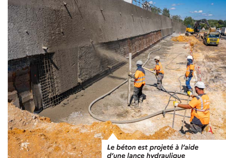
La paroi de soutènement est équipée de clous de 2 à 11m de long, disposés tous les 2m horizontalement et tous les 1,5 m verticalement
