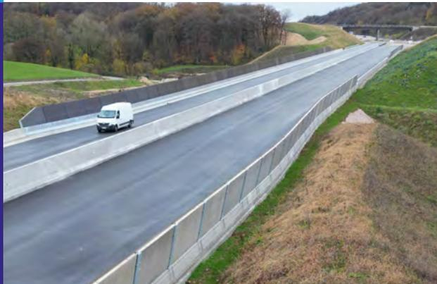
La pose des écrans acoustiques fin 2023 vient compléter les merlons déjà réalisés avec les matériaux du site.
