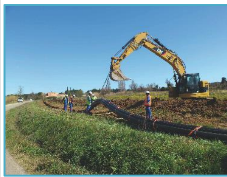
Pose des fourreaux
