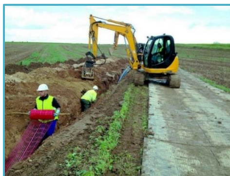
Enrobage terre ou sable et pose de grillage avertisseur
