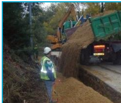
Remblaiement et remise en état du sol (terre végétale)
