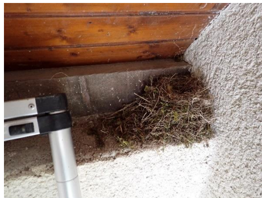
Figure 28 : Hangar à bateaux : nid non occupé
