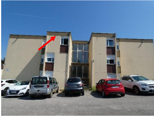
Figure 12 : Pipistrelle entre la rive de toit et la maçonnerie
