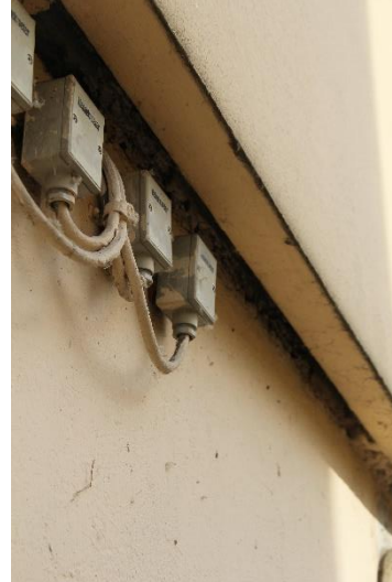
Figure 9 : Espace entre deux éléments de maçonnerie
