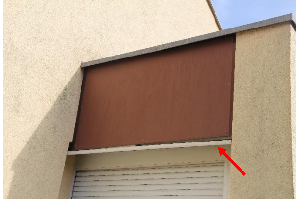
Figure 11 : Disjointement permettant d'accéder à l'isolant
