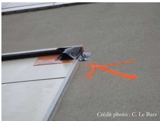
Figure 22 : Exemple de système anti-retour équipé d'une casquette anti-retour
