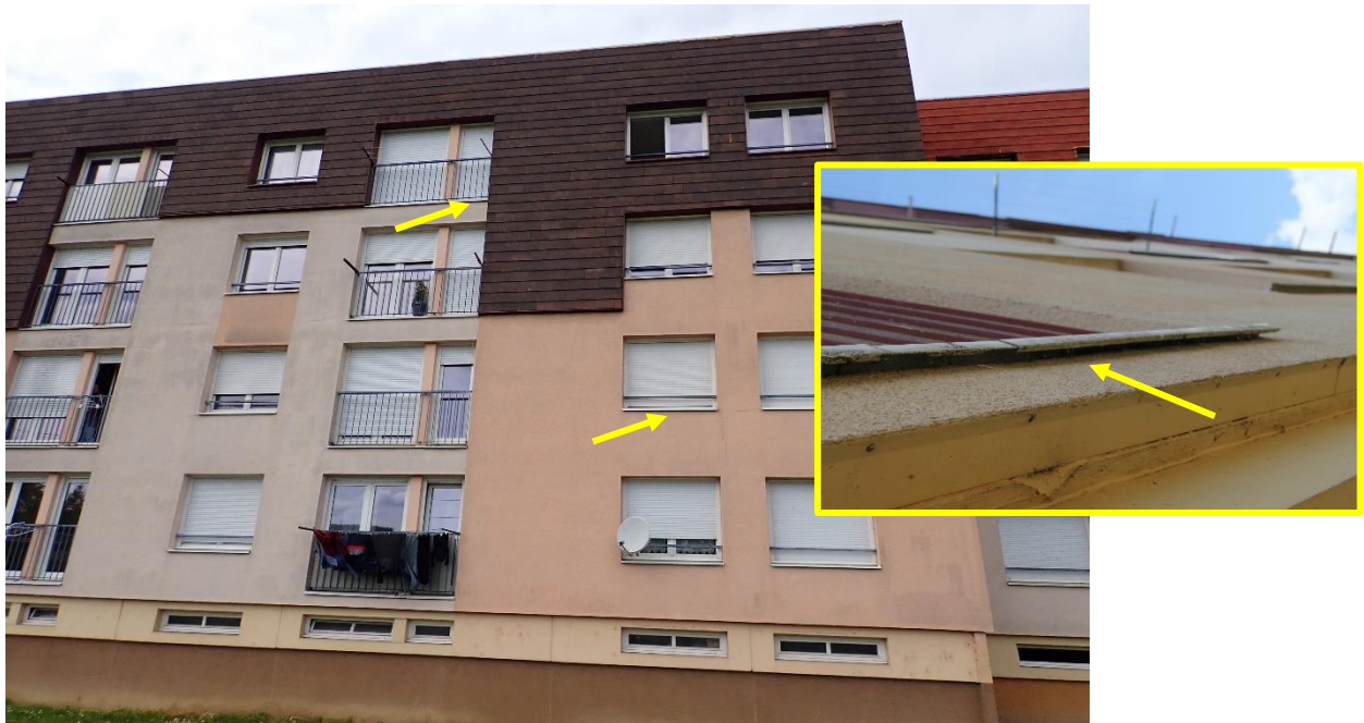
Figure 10 : Tablette en métal au niveau des rebords de fenêtres et des maçonneries
