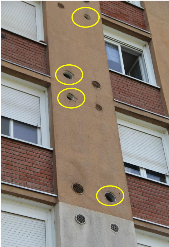
Figure 14 : Absence de grille d'aération
