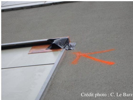
Figure 30 : Exemple de système anti-retour équipée d'une casquette anti-retour
