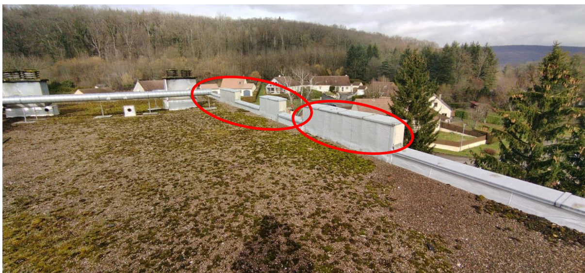
Figure 36 : Acrotère creux permettant l'accueil des nichoirs ou les gîtes artificiels au sein de la tour
