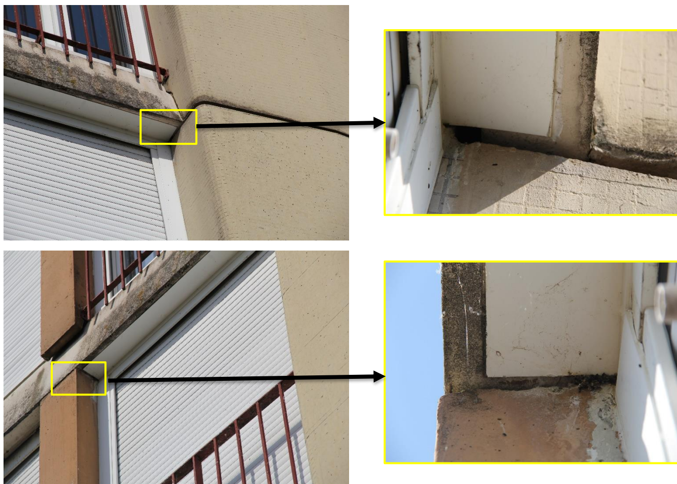
Figure 22 : Localisation de la colonie dans les joints horizontaux de la tour.
