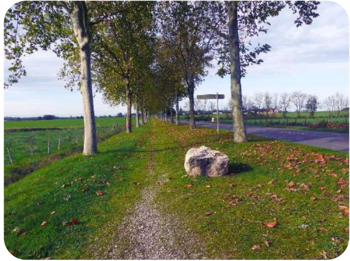
Photo 22 : Des blocs de pierre à supprimer (A. GINDA, 2023)
