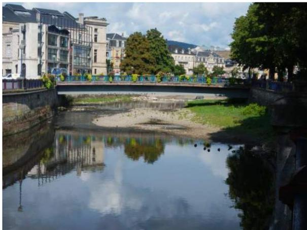
Figure 48 : Présence de blocs, cailloux et atterrissements en aval immédiat du seuil de la passerelle des Arts
