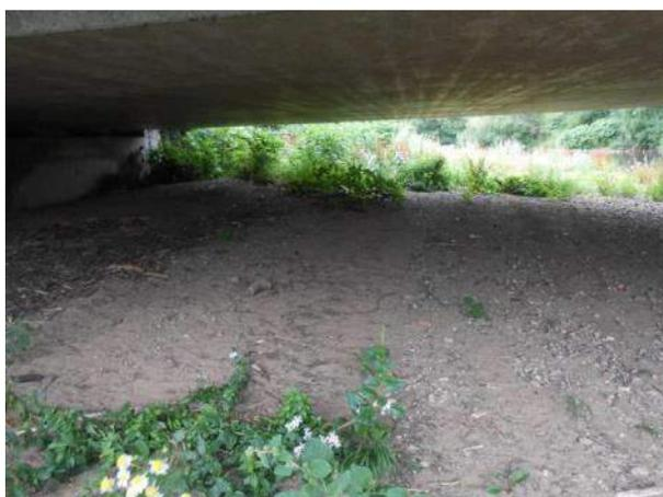
Figure 38 : Atterrissement sous le pont du Magasin
