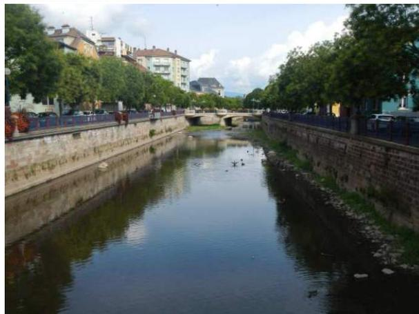
Figure 30 : Profil en travers artificialisé en centre-ville
