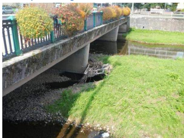
Figure 39 : Atterrissement en amont du pont Clémenceau
