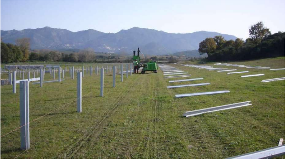
Figure 82 : Eventuel battage des pieux
