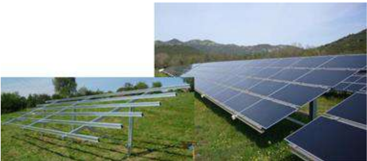
Figure 83 : Pose des tables photovoltaïques
