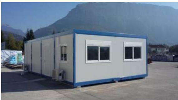
Figure 80 : Exemple d'une base vie
