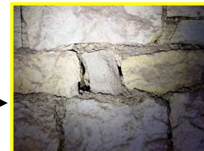
Disjointements dans le mur
