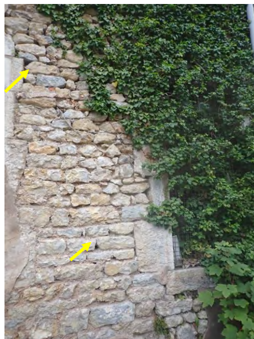
Disjointements dans le mur
