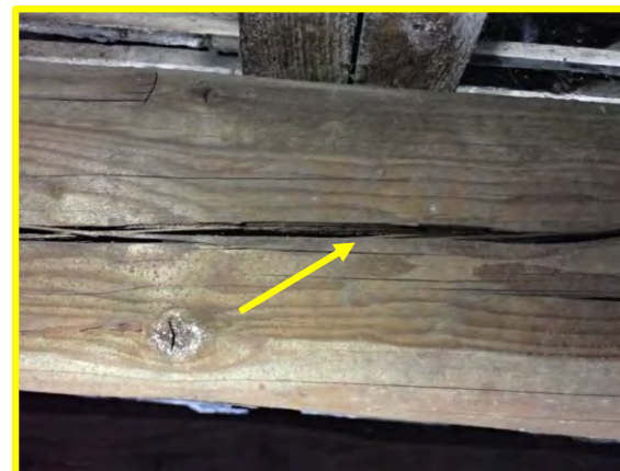
Fissures dans la charpente
