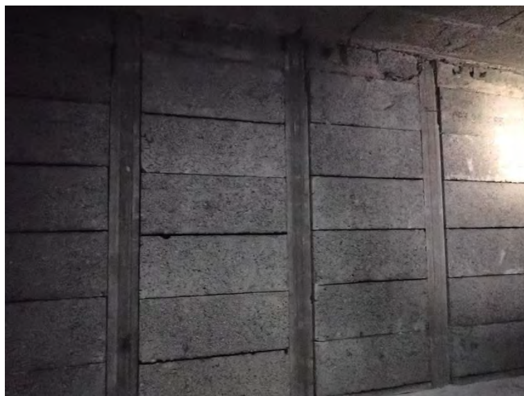
Figure 98 : Plafond en parpaing
