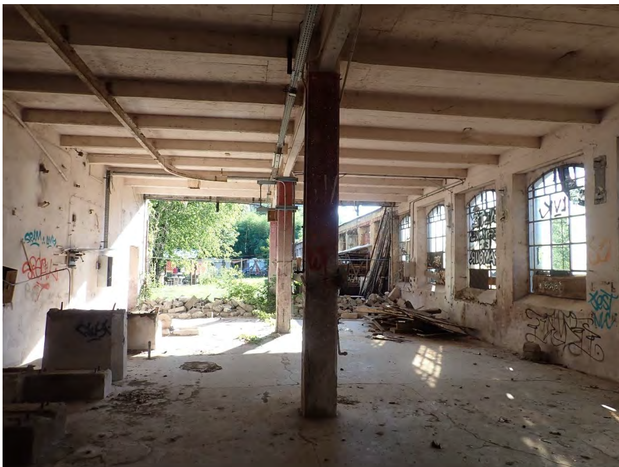
Figure 101 : Exemples d'accès au rez-de-chaussée du bâtiment E : mur manquant et fenêtres cassées
