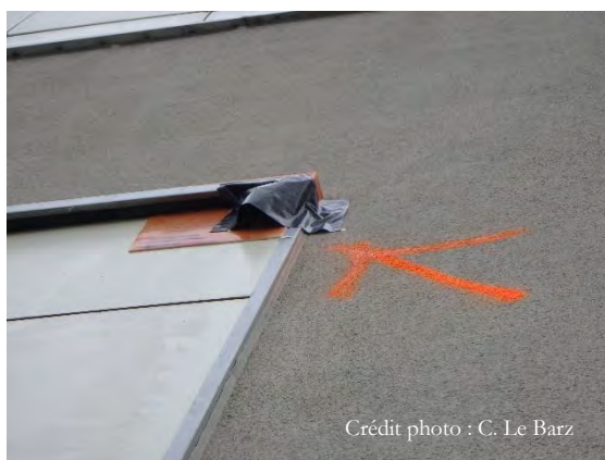
Figure 79 : Exemple de système anti-retour (SAR) équipée d'une casquette anti-retour
