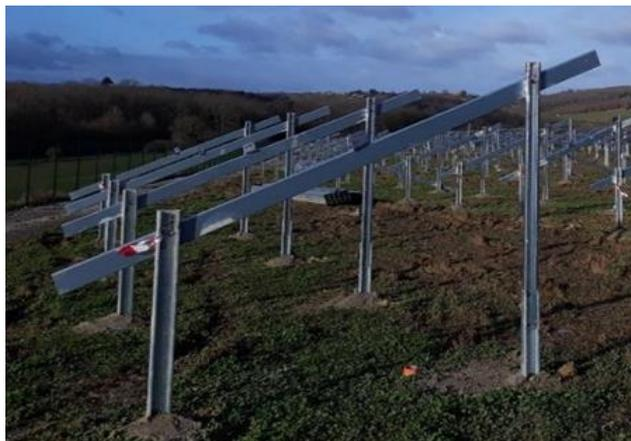
Illustration 10 : Exemple de peux forrés bétonnés
