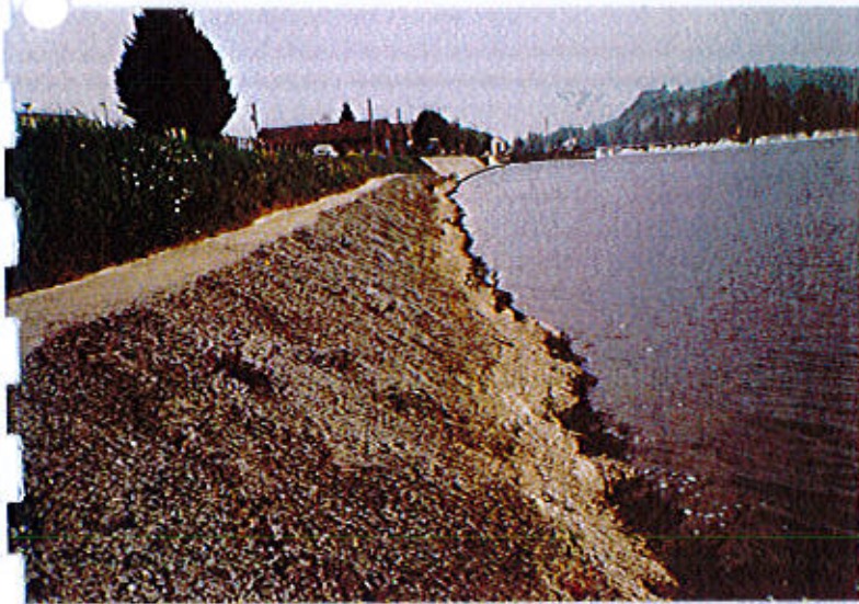
La rive droite de l'Yonne, en aval du barrage : cimentée, elle est totalement inhospitalière pour la faune et la flore.
