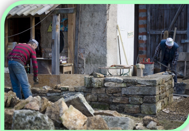
Image : Chantier participatif
