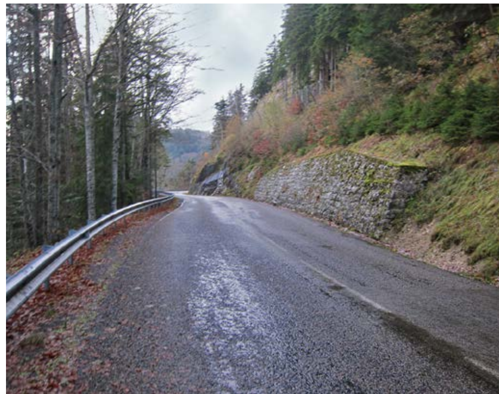
La pente et les chutes de pierres obligent à de nombreux dispositifs de protection
