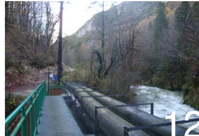
Passerelle métallique et conduite forcée
