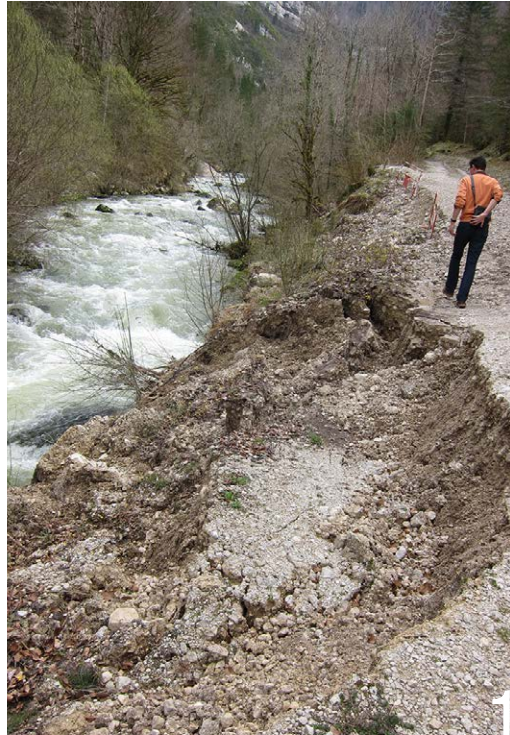
L'érosion des berges est réelle et aggravée par l'installation de structures telles que la conduite forcée EDF dans le chemin.
