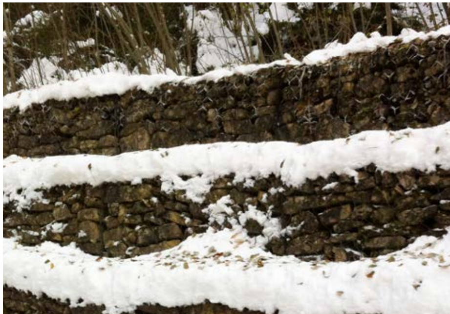
Soutènements en gabion le long de la RD 25.
