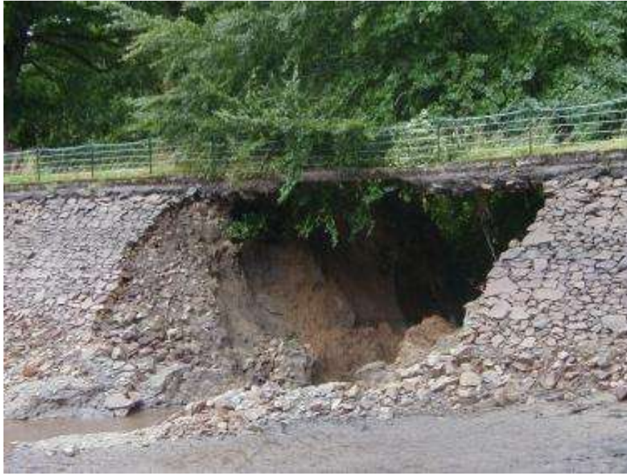
Figure 4 : Brèche initiée par le mécanisme d'érosion de contact sur le barrage des Ouches (Source : Irstea)
