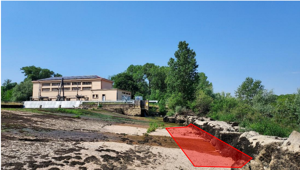
Figure 39. Filtre à l'aval des seuils
