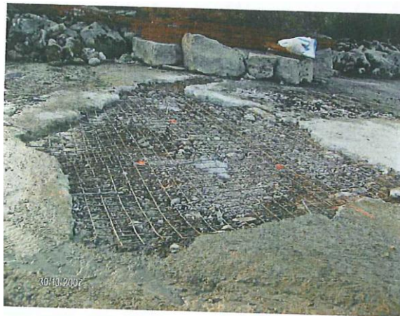
Figure 40. Photographie des travaux de 2007 (même type de travaux sur ce barrage)
