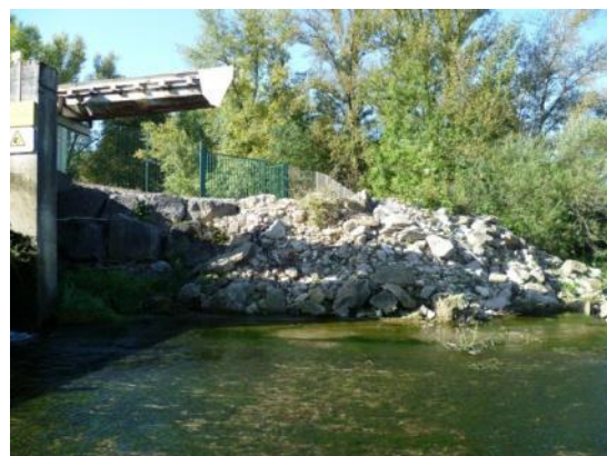
Figure 10 : Vue de l'aval du clapet depuis le seuil aval
