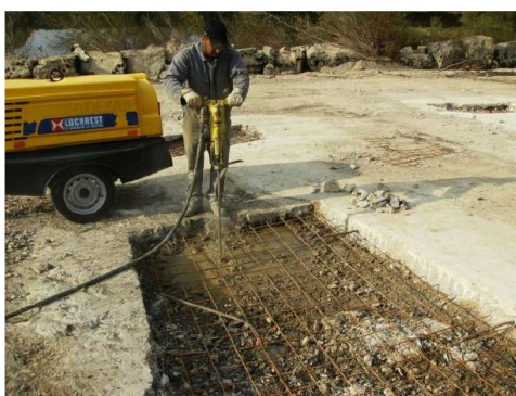
Figure 42. Photographies des travaux de 2007 (même type de travaux sur ce barrage)
