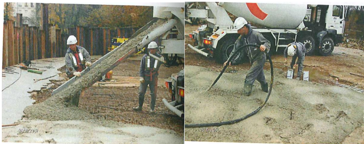
Figure 43. Photographies de travaux de 2007 (même type de travaux sur ce barrage)
