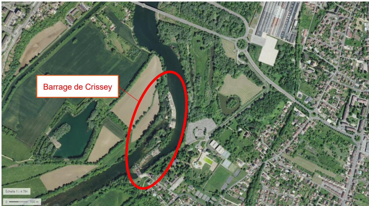
Figure 3: vue aérienne du barrage, objet des travaux
