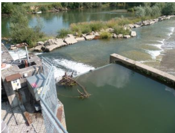
Figure 9 : Vue du clapet depuis l'amont
