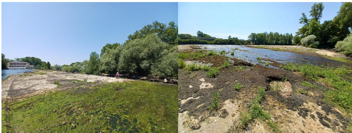
Figure 37. Visuels du type de végétation à débroussailler, nettoyer et dévégétaliser.
