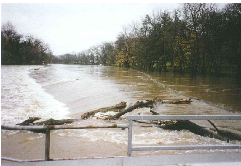
Figure 45 : Seuil aval – Épisode de crue (novembre 1996 : ressaut hydraulique régulier)
