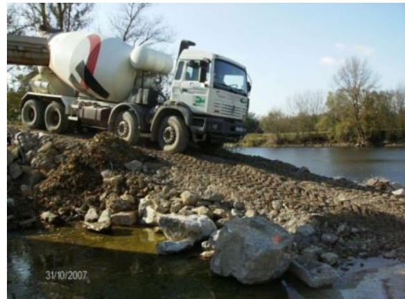
Figure 25 : Piste d'accès sur l'île des Pêcheurs (photographie issue du rapport de fin de travaux de 2007)
