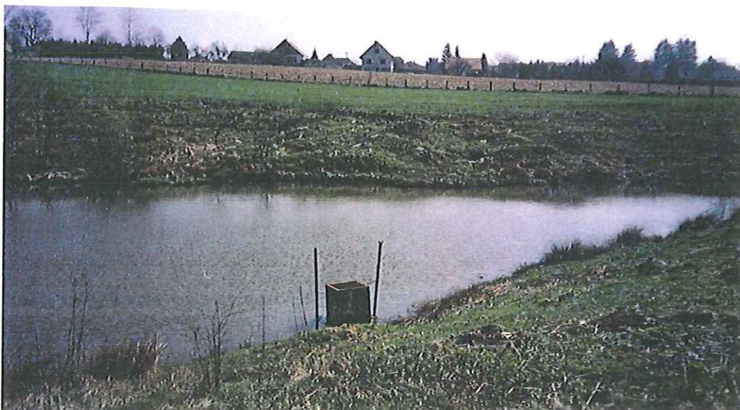
Les eaux de ce premier bassin se déversent dans un second bassin de rétention par l'intermédiaire d'une canalisation de  $\varnothing$  400 mm puis dans un fossé. Ce second bassin est plus petit puisque d'un volume de 280 m<sup>3</sup>. Il se situe juste au dessus des habitations de la Rue Champ de Mai.
