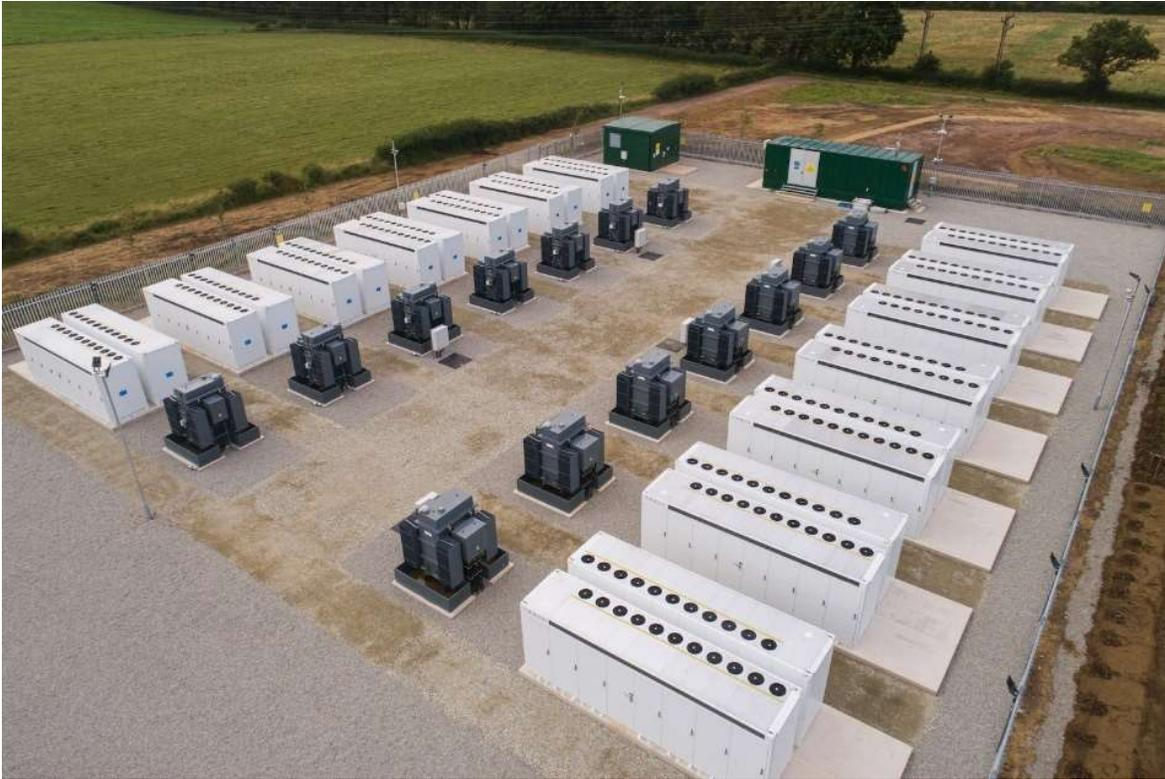
Figure 13 : Vue aérienne de la centrale de stockage de Contego (34 MW / 68 MWh), développée et opérée par Harmony Energy
