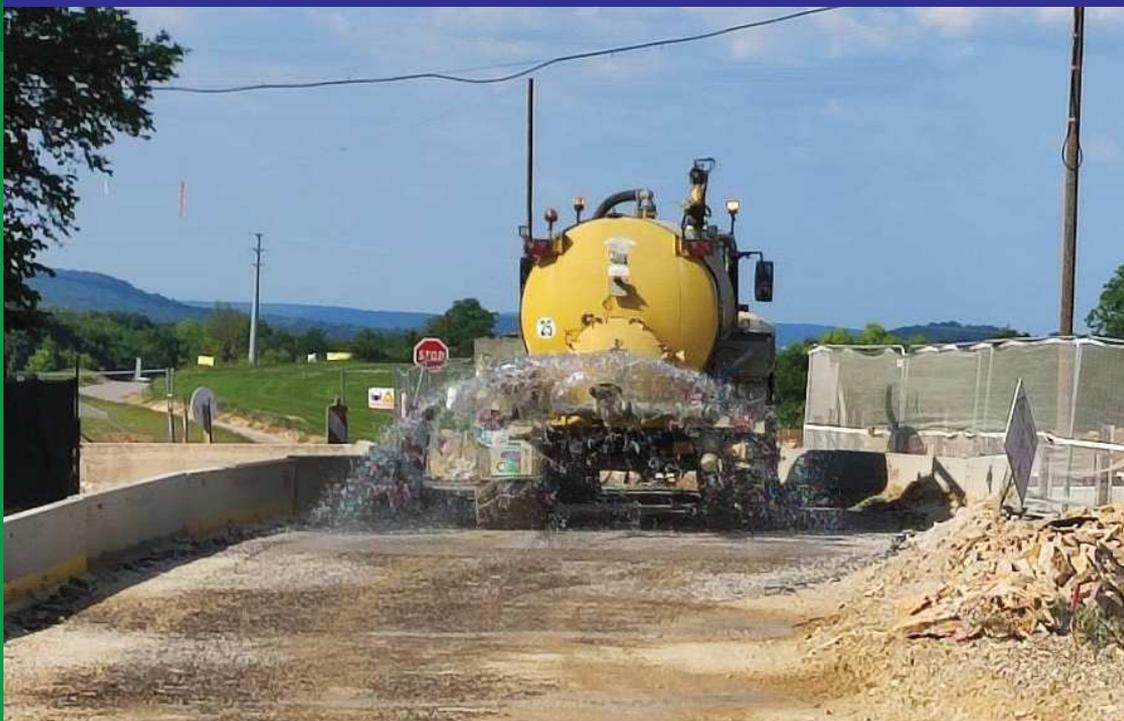
Le chantier, proche de nombreux riverains et de l'actuelle RN57, fait l'objet d'une procédure d'arrosage des pistes de circulation des engins permettant de limiter l'envol des poussières.
