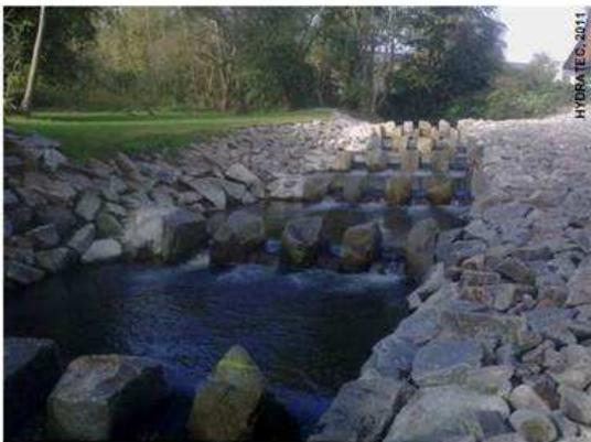
En période de basses eaux, une lame d'eau de 20 cm (minimum) s'écoule entre les blocs. Ces conditions assurent le passage d'un grand nombre d'espèces.
