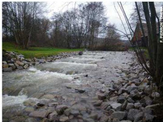
A deux fois le module, l'eau surverse par-dessus les blocs et des turbulences apparaissent (eaux blanches). Le dispositif atteint sa limite de fonctionnement et devient sélectif des espèces à hautes capacités de nage (grands salmonidés).
