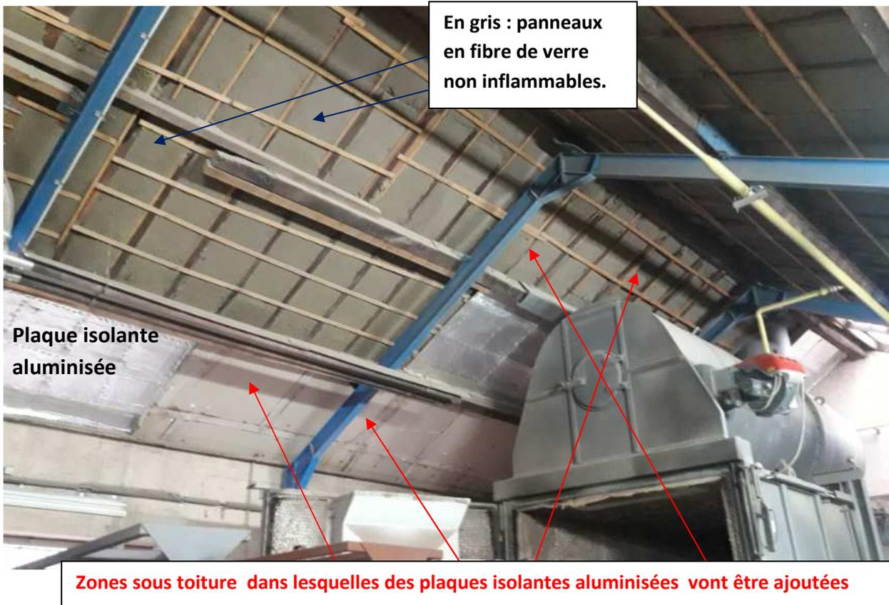
Des mesures constructives spécifiques sont exigées pour le bâtiment abritant les fours de décapage thermique (voir article 11.1 Titre II de l'arrêté préfectoral). L'exploitant ne peut pas garantir le respect de l'ensemble des dispositions. Il demande leur remplacement dans le futur arrêté préfectoral par les moyens constructifs existants comme justifié ci dessous :
