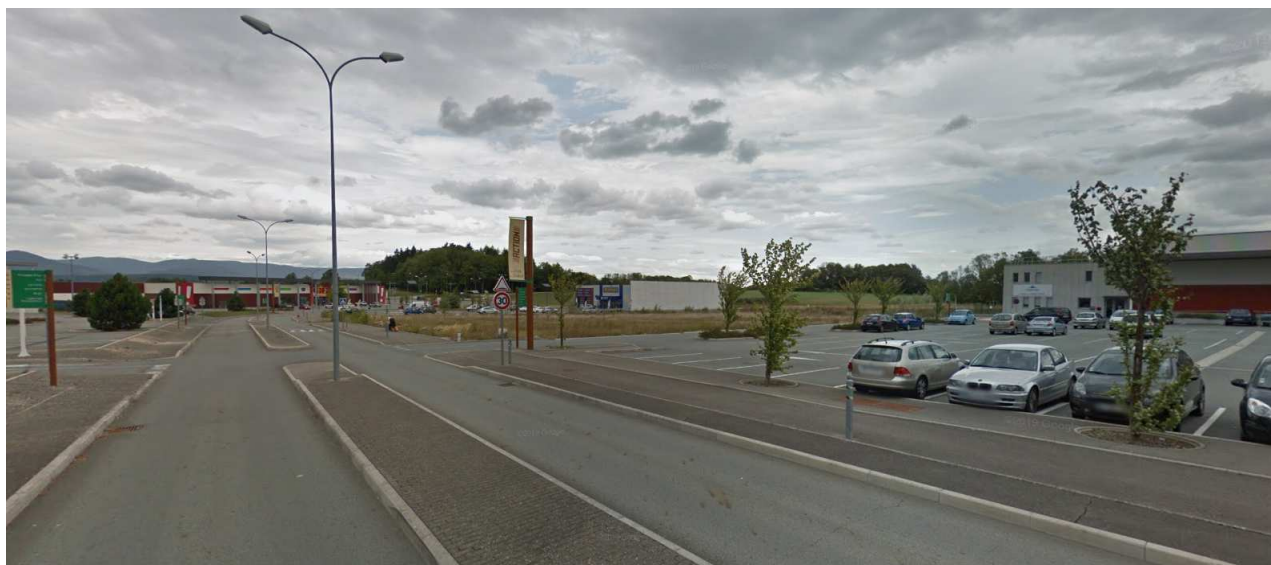
Vue 03, depuis la rue du Tilleul, axe routier du parc commercial, vue éloignée sur la parcelle.
