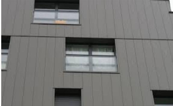
Bardage plan, lame de 300 mm
