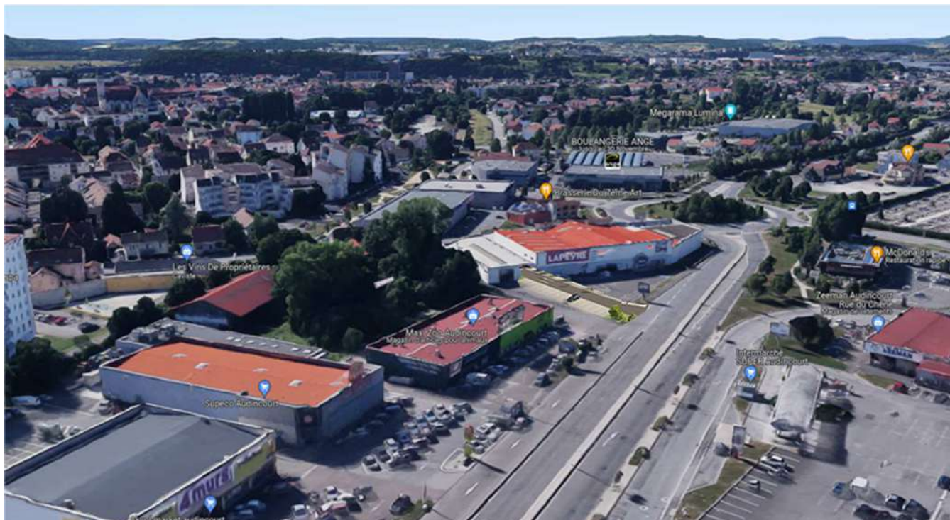
B-Vue aérienne existante
