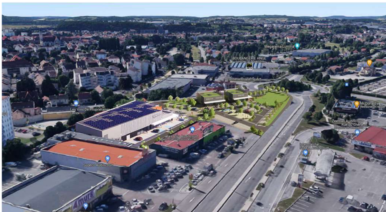
B-Vue aérienne sur le projet
