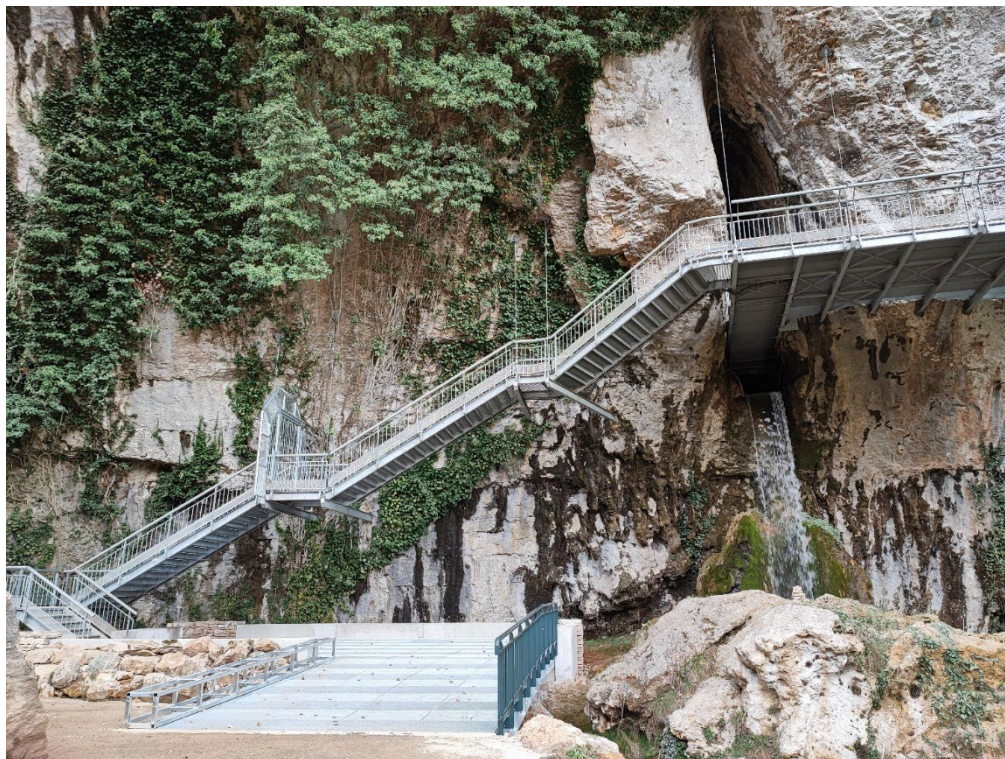
Photo 1 - Photo de la nouvelle passerelle et de la plateforme d'accueil
