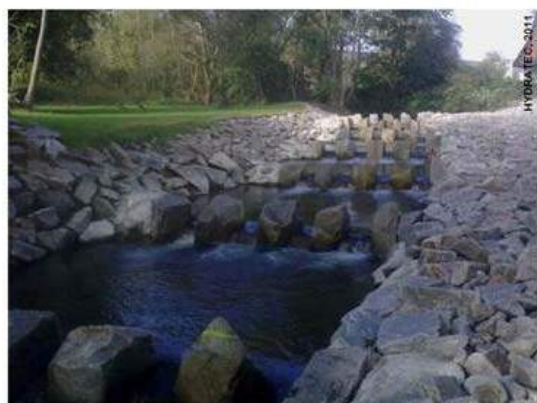
coupe technique – ouvrage de rétablissement piscicole – seuil de la STEP( projet CAB)
