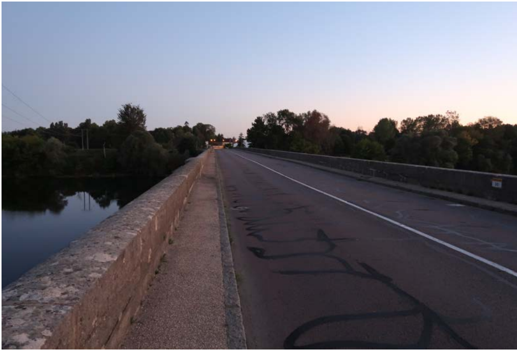
Photo 5. Vu de l'ouvrage © P. BRUNOD
