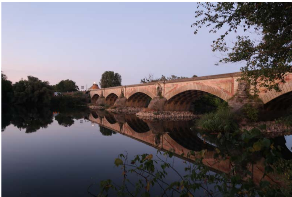
Photo 3. Vu de l'ouvrage en aval © P. BRUNOD
