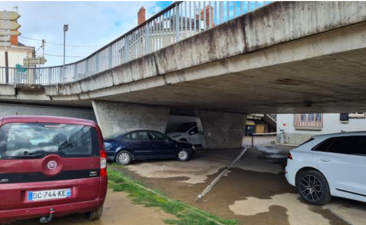
Vue sous le viaduc
