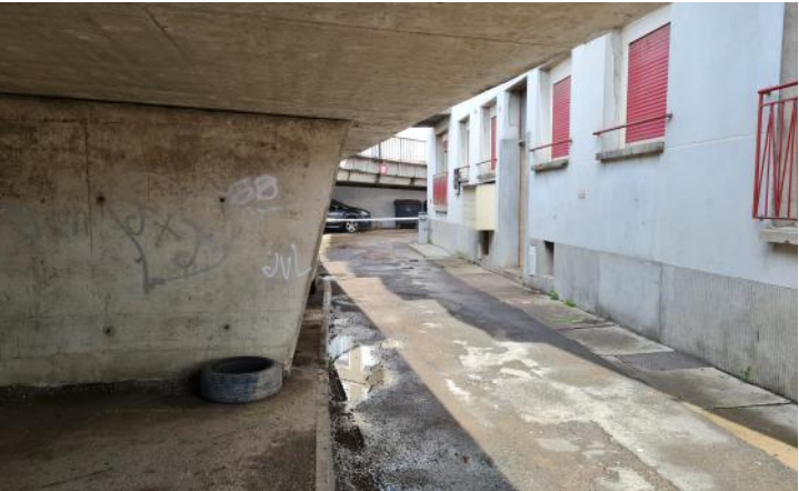
Entrée de la résidence donnant sous le viaduc avec contrôle d'accès
