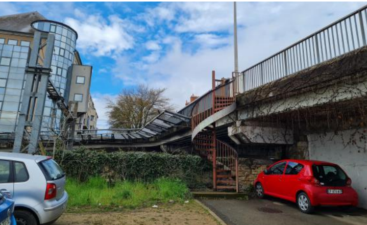
L'escalier colimaçon métallique
