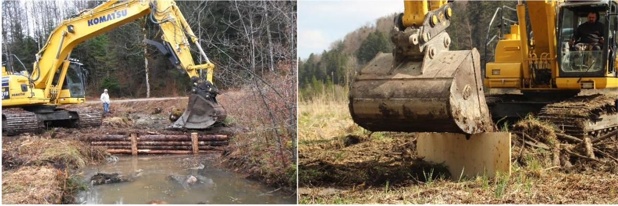
Figure 34 : Exemples de mise en place de bouchons. Gauche : fascines. Droite : panneau triplis (© Jura Natura Services).
