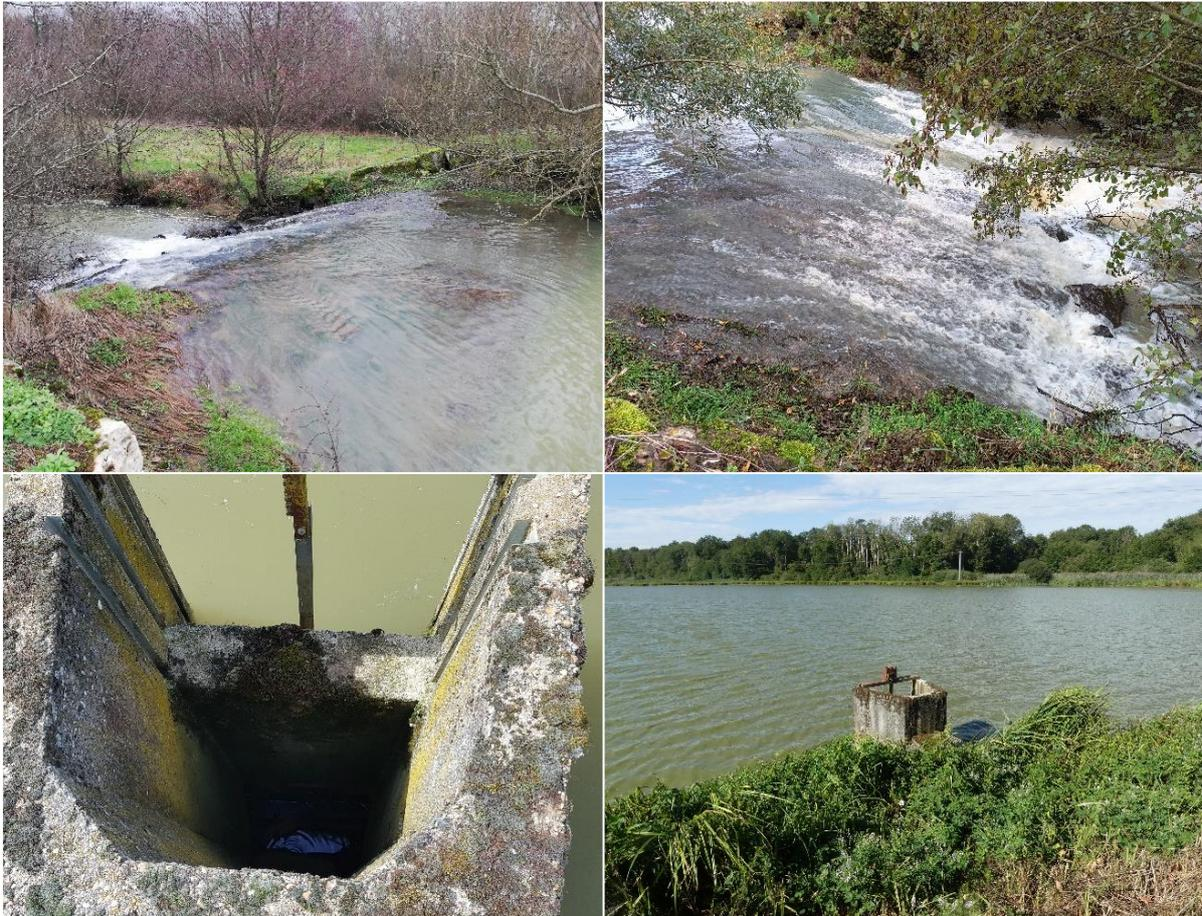
Figure 8 : Haut : surverse. Bas : ouvrage de vidange.
