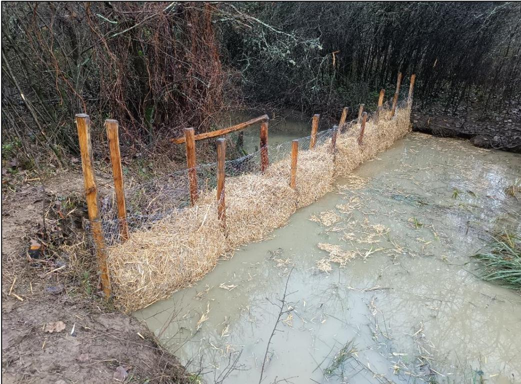
Figure 57 : Exemple de filtre à paille, déjà en place à l'exutoire de l'étang.
