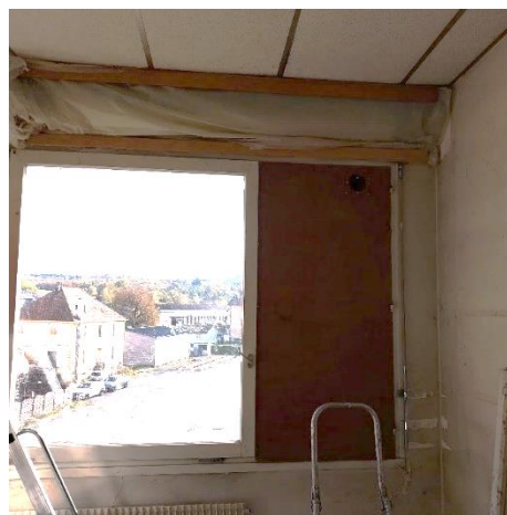
Figure 7 : Dispositif anti-retour installé sur l'unité 2, vu de l'extérieur et de l'intérieur
