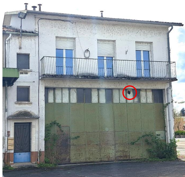
Figure 6 : Fenêtre de l'unité 4 cassée, permettant à la faune d'entrer dans le bâtiment
