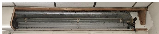
Figure 5 : Caisson de volet manquant sur une des fenêtres du deuxième étage de l'unité 2, permettant à la faune d'entrer dans le bâtiment
