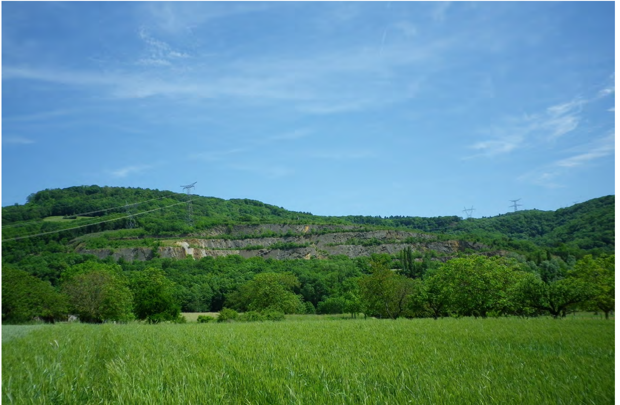
front étagé de la carrière de Cuiseaux dans le Revermont
