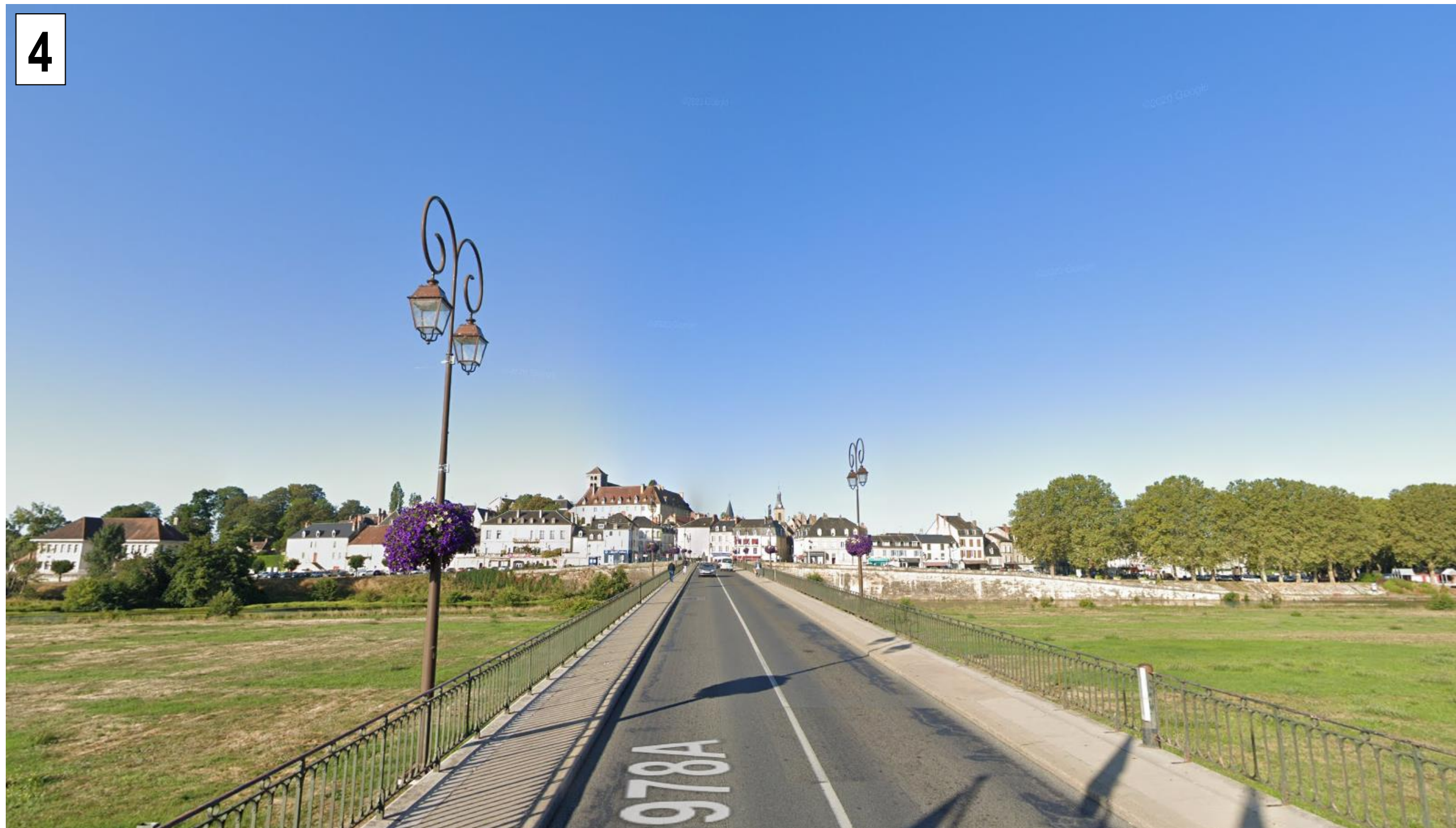
Vue depuis le pont, en direction du Vieux Bourg (août 2019)
