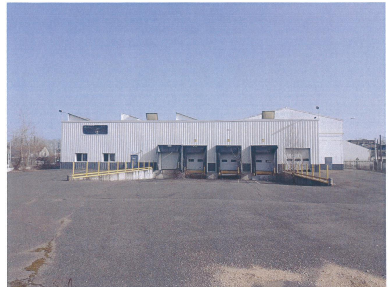
Photo N°10 : ACCES OUEST C.COMMERCIAL
